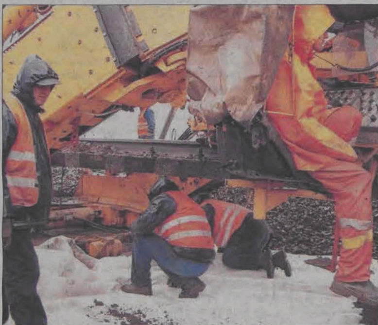
Etap drugi: układanie folii izolacyjnej pod torowiskiem.
