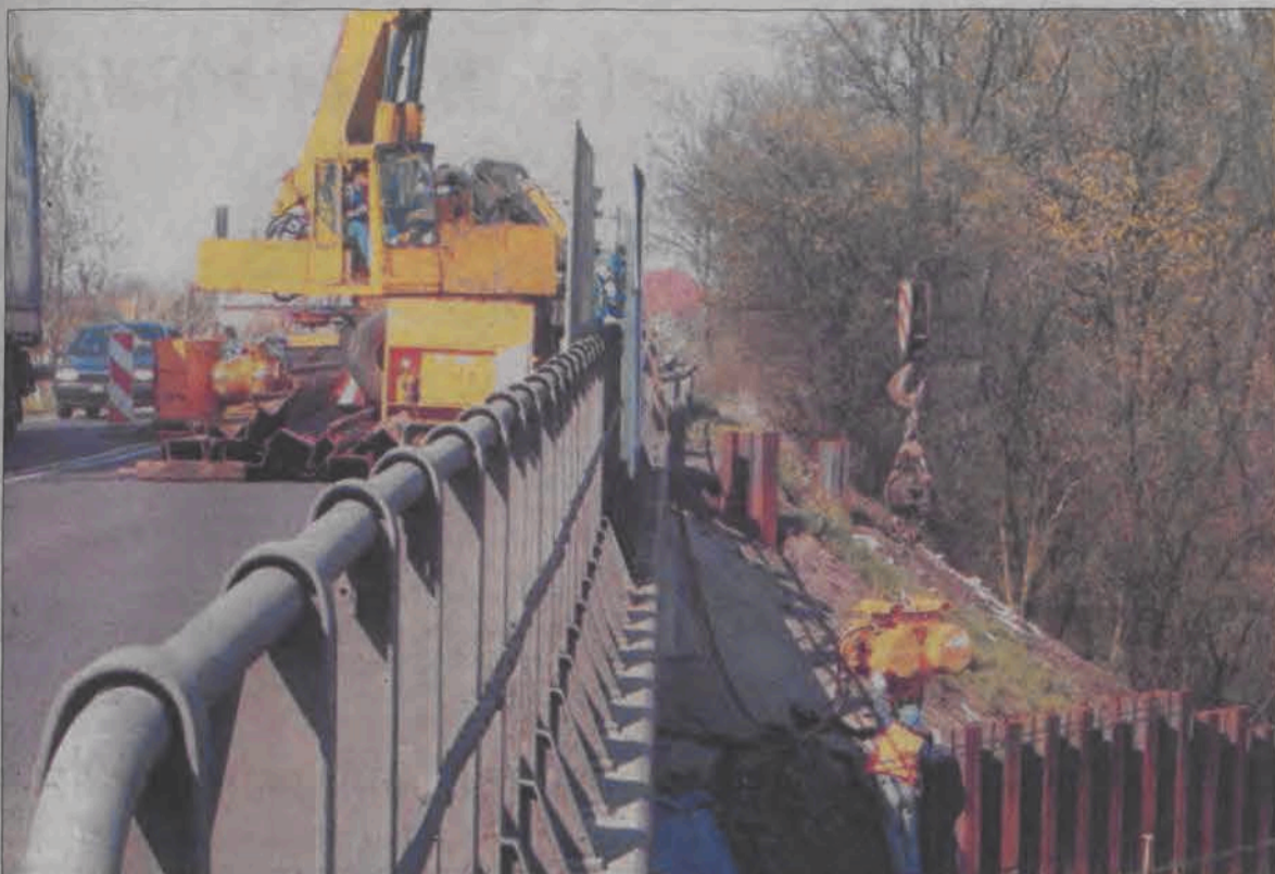
Prace przy umacnianiu skarpy wiaduktu kolejowego już niekiedy powodują korki na Poznańskiej, dając przedsmak tego, co latem czekać nas będzie na obwodnicy.
