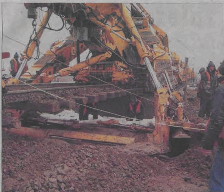
Etap pierwszy: „wycinanie” fundamentu pod uniesionym torowiskiem.
