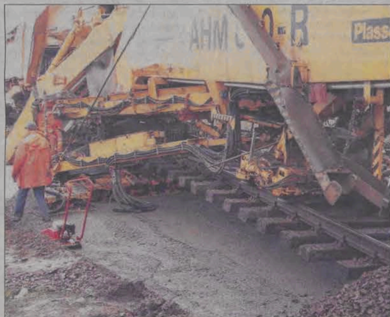
Etap trzeci: niesort jest zagęszczany, torowisko zostanie opuszczone i zasypane tłuczniem.
