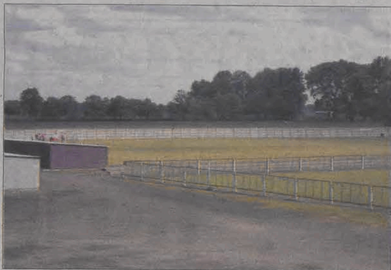
Droga ewakuacyjna ma powstać za trzyschodkową trybuną tuż za ogrodzeniem boiska. Ostatnim elementem modernizacji stadionu będzie likwidacja części blaszanych garaży, z którą trzeba się będzie liczyć za około dwa lata.
