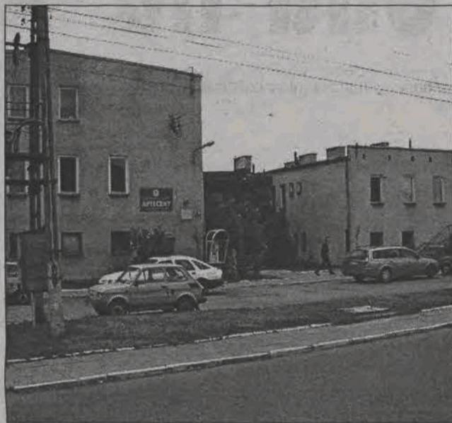
Ośrodek zdrowia w Kiemozi to jeden z przykładów drogiego w utrzymaniu, nie w pełni wykorzystanego obiektu.
