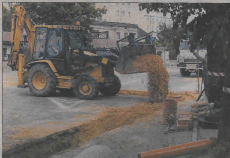
Prace przy rondzie rozpoczęły się od wykonywania sieci kanalizacyjnej oraz chodników.
