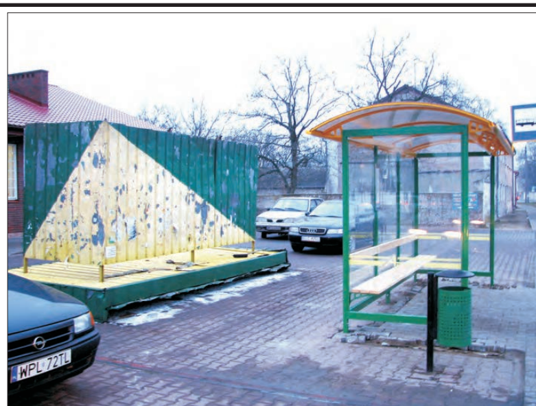
Nowa wiatra przystankowa zamontowana została 28 grudnia na przystanku przy ul. Warszawskiej w Sannikach. Urząd Gminy zamówił wiatę w spółce Arrel w Gliwicach. Z transportem i montażem kosztowała ona 7.280 zł. Wiatra jest przeszklona, a jej elementy konstrukcyjne są ocynkowane i malowane proszkowo. Jest na nie gwarancja 100 miesięcy. Stara wiatra zostanie ustawiona na przystanku w Barciku. (mwk)
