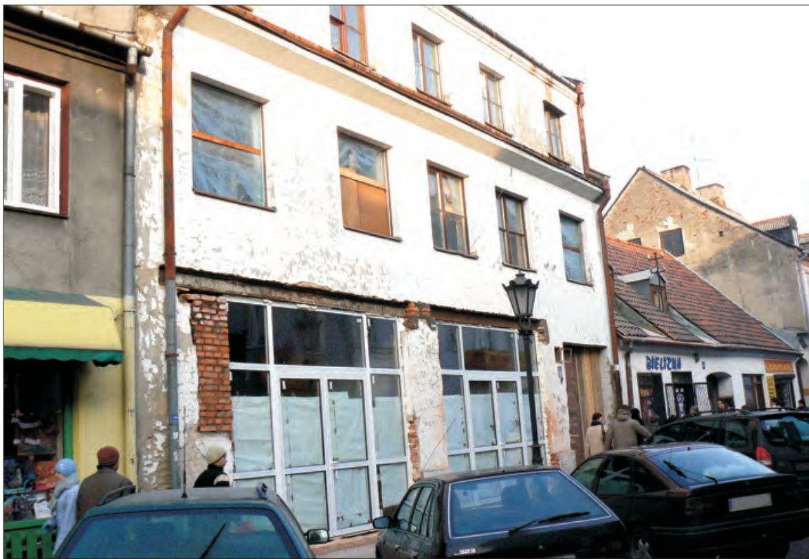
Przed Bożym Narodzeniem w kamienicy przy ul. Zduńskiej 38 zamontowane zostały duże okna wystawowe. Z zewnątrz widać, że strop dotychczasowej pierwszej kondygnacji został rozbity, a trwająca modernizacja ma na celu utworzenie lokali handlowych lub usługowych. O budynku wiele razy pisaliśmy na naszych łamach z powodu walki jego właściciela, lekarza Mariusza P., z lokatorami, zmierzającej do wykwaterowania ich. Jak się dowiadujemy, Mariusz P., do niedawna kierownik jednego z podłowickich NZOZ-ów, sprzedał go obywatelowi Włoch.
