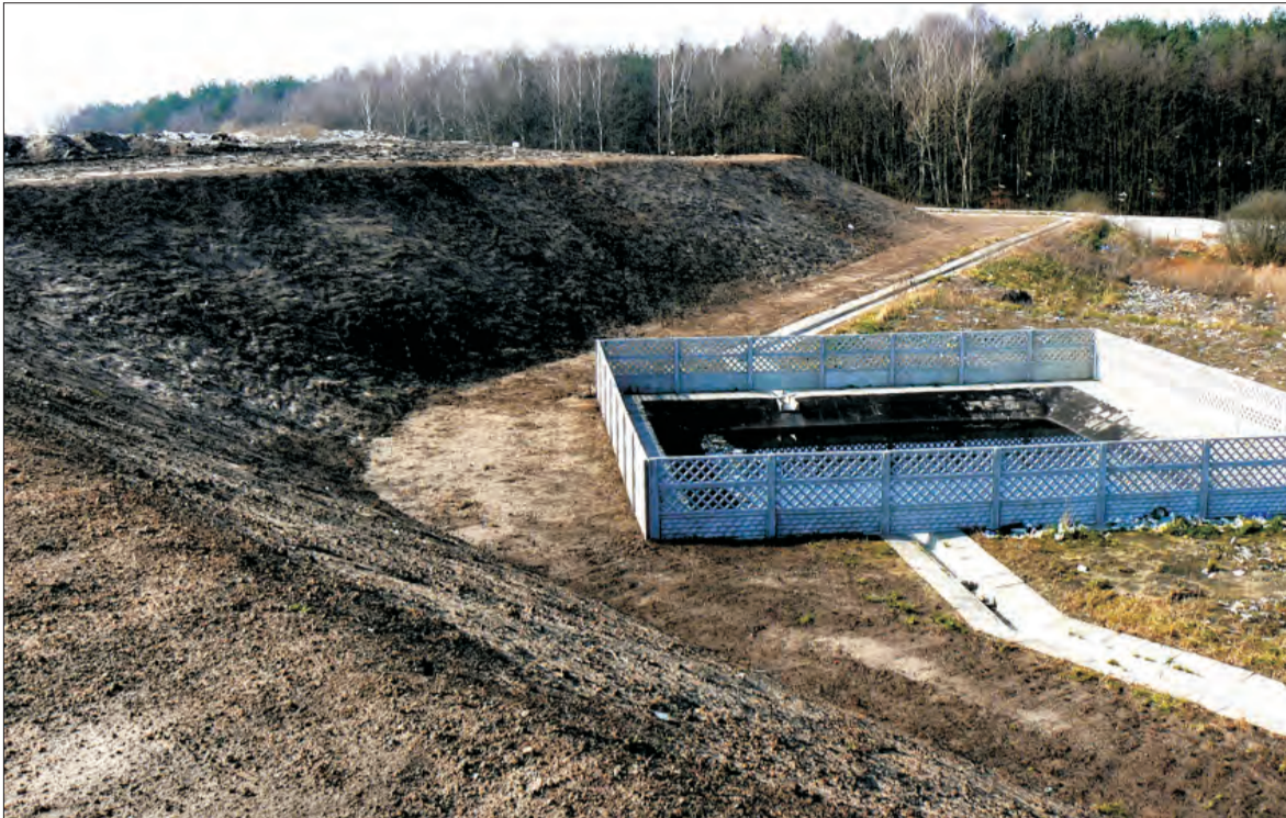
Na nowo urządzonych skarpach wysypiska wiosną zostanie posadzona trawa.
