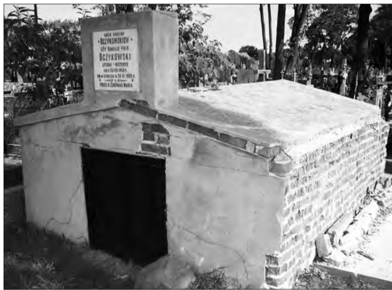
Zniszczony grób Romualda Oczykowskiego - stan obecny.
