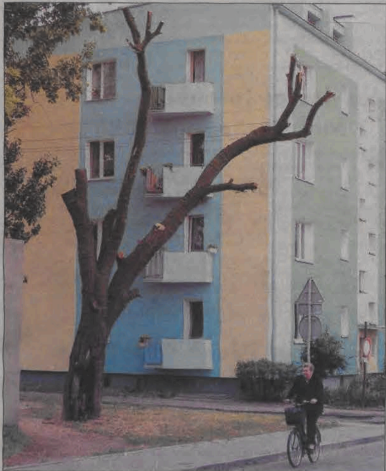
ŁSM prowadzi na swoim terenie wycinanie drzew. Na zdjęciu morwa na os. Tkaczew. Drzewo stoi i czeka na ścięcie od kilku dni, na tle świeżo odremontowanej fasady bloku sterczące kikuty robią przygnębiające wrażenie.
