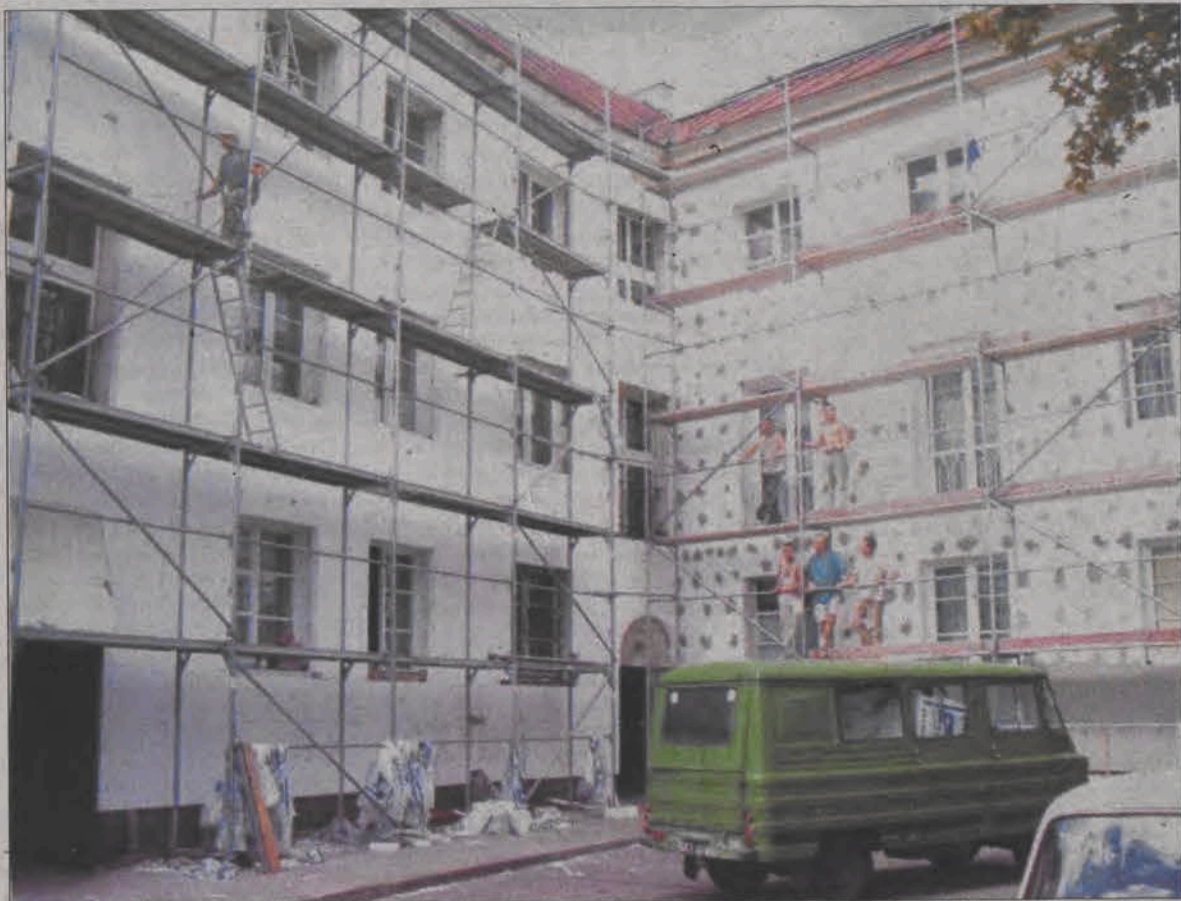
Ocieplanie kamienic na 11 Listopada. W ubiegłym tygodniu rozpoczęło się ocieplanie bloków ŁSM na ulicy 11 Listopada. Prace wykonuje firma „Wikam” ze Skierniewic, a potrwać one ponad dwa miesiące, ponieważ powierzchnia ścian kamienic jest duża. Na razie rusztowania ustawione zostały od strony przedszkola, dopiero po ociepleniu tej ściany staną na bardziej uczęszczanym chodniku od strony Starego Rynku. (eb)
