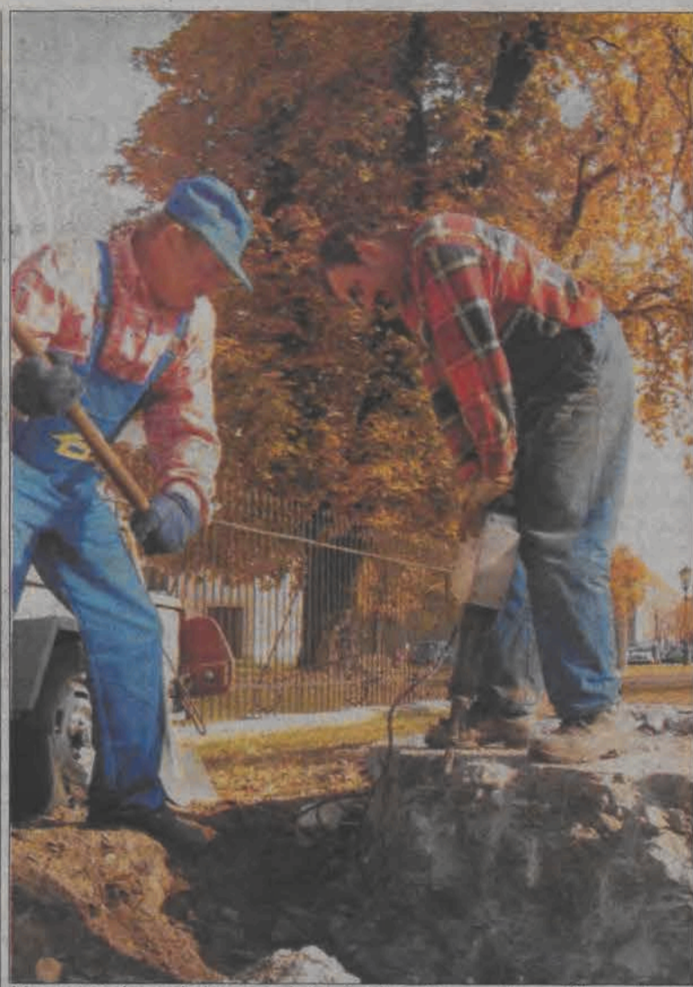
Maszynowo i ręcznie kruszono beton fundamentu pomnika na Starym Rynku, w jego wnętrzu znaleziono dokumenty dotyczące jego powstania.
