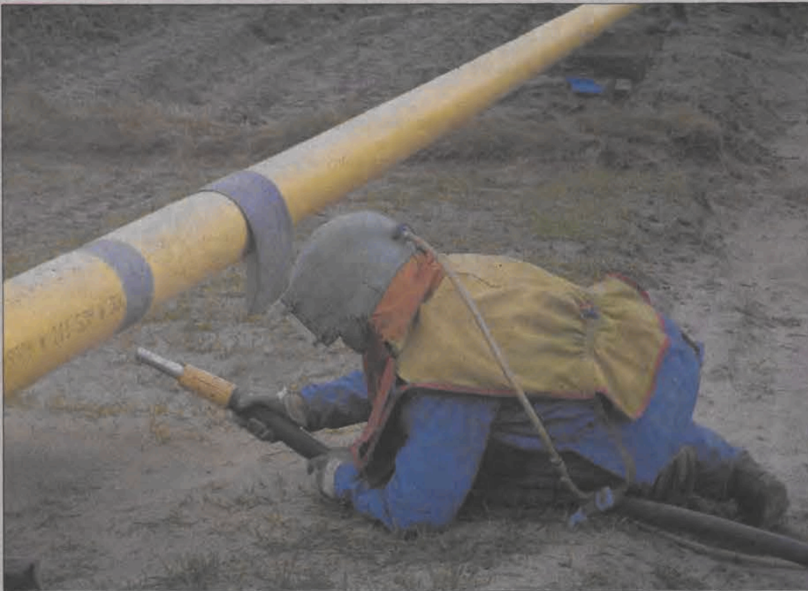
W taki strój ochronny ubrany musi być pracownik wykonujący czyszczenie łączni rur przed ich zaizolowaniem.
