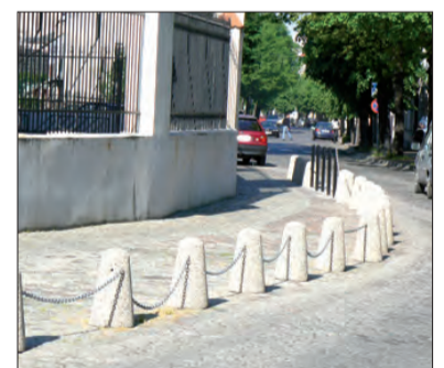
Wiele z tych betonowych słupków było przewróconych przez wandalów.
