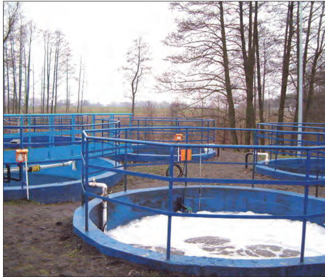
Radni ustalili, że oczyszczalnia w Domaniewicach zostanie rozbudowana o kolejne dwa zbiorniki i będzie to jedyna oczyszczalnia w gminie.
