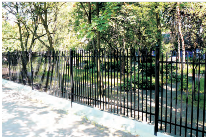
Muzeum ogrodzone na nowo. Firma Damir z Łowicza na początku czerwca zdemontowała całe ogrodzenie skansenu, przy muzeum w Łowiczu od strony ul. 3 Maja, na długości 50 m wraz z 10-metrową bramą. Nowy płot nawiązuje stylem do ogrodzenia restauracji „Pod Pelikanem”, jest wykonany ze stalowych elementów. Wymiana ogrodzenia kosztowała około 13 tys. zł netto.
