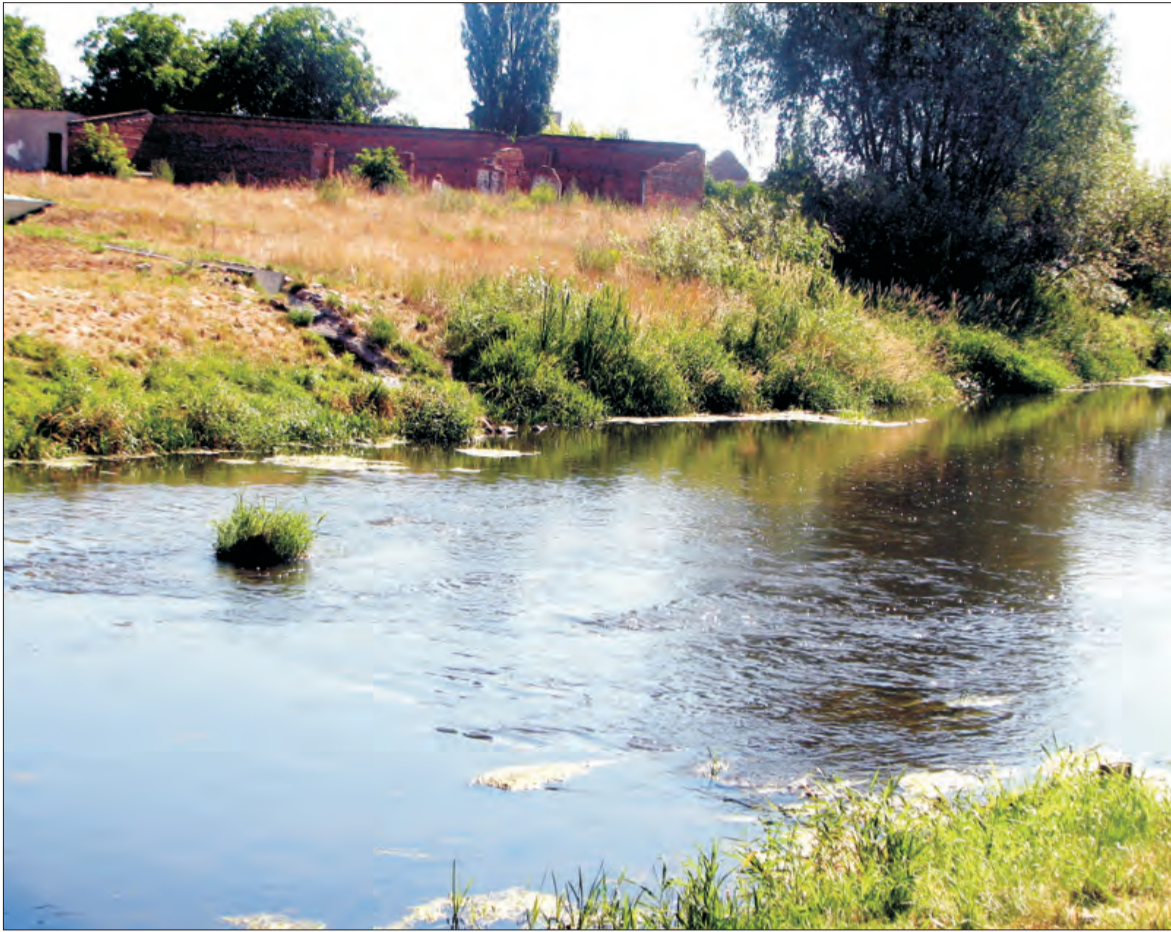
CORAZ MNIEJ WODY. Jak podaje łowicki Inspektorat Wojewódzkiego Zarządu Melioracji i Urządzeń Wodnych, poziom wody w Bzurze wynosił w piątek (27.06) 1,56 metra, a od początku tygodnia obniżył się jeszcze o kilka centymetrów. Na obszarze województwa niektóre mniejsze rzeki w ogóle przestały prowadzić wodę. Zwykle Bzura utrzymuje się na poziomie dwóch metrów i powyżej.
