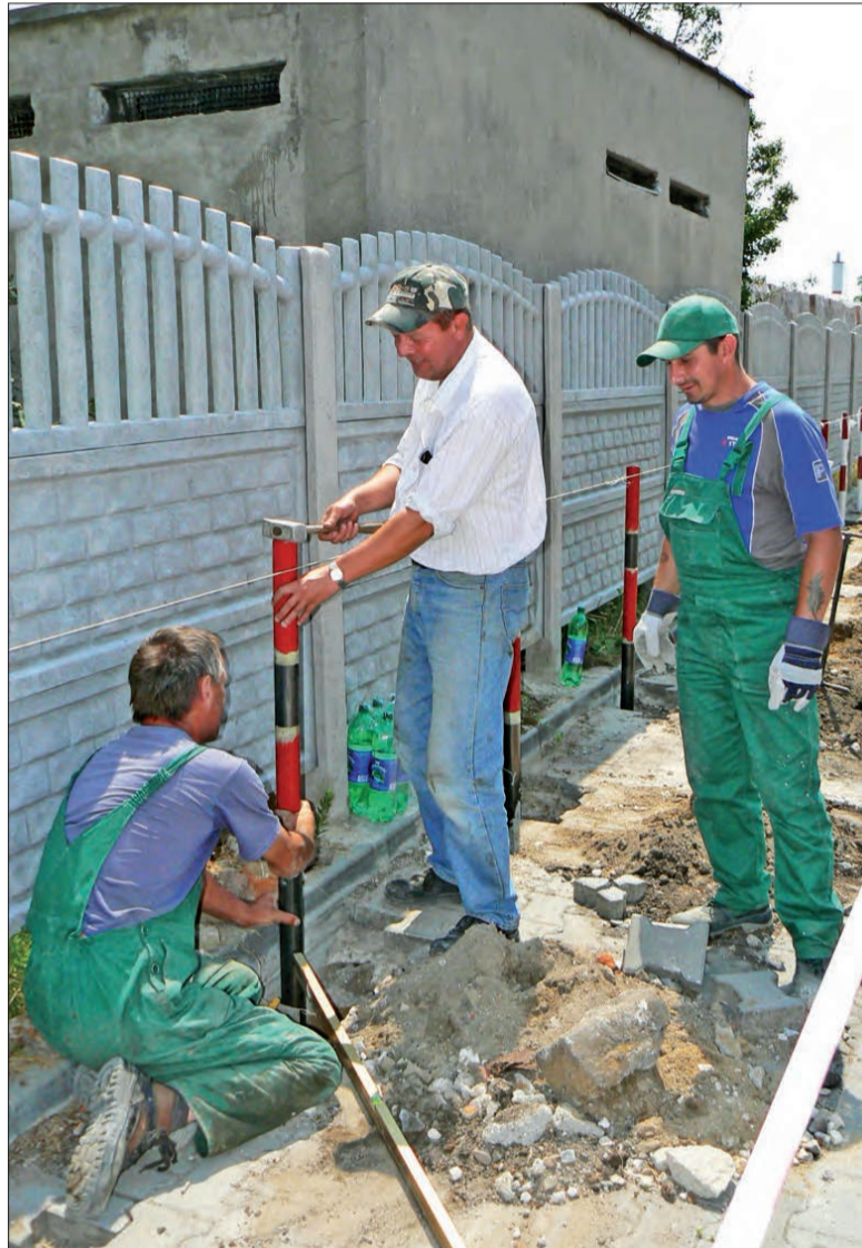
(tb) Słupki mają uchronić betonowy płot przez zniszczeniem, na zdjęciu pracownicy ZUK przy ich montażu.
