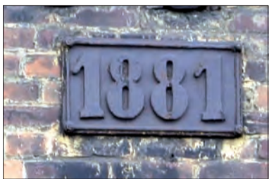
Tabliczka z datą pobudowania wieży.
