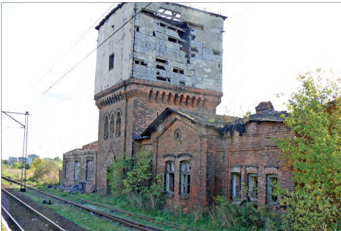
W połowie zabytek, w połowie płyty wiórowo-betonowe. Już wkrótce ma zostać zrównany z ziemią.
