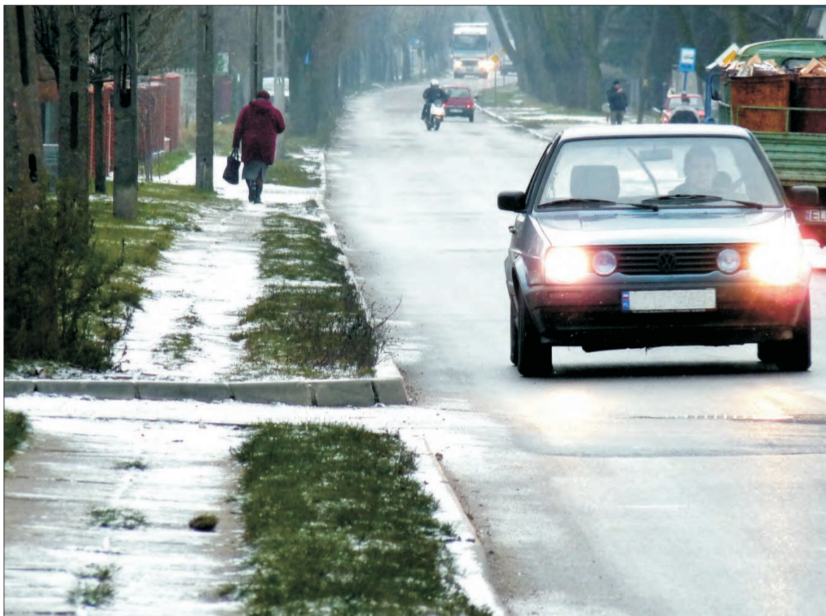
Chodnik przy ul. Armii Krajowej, w przyszłym roku będzie z kostki i do końca terenu zabudowy jednorodzinnej.
