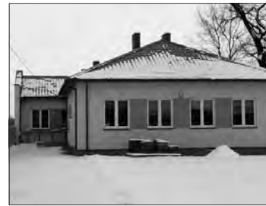
Bobrowniki - nowo powstały budynek filii GOK w Nieborowie.
