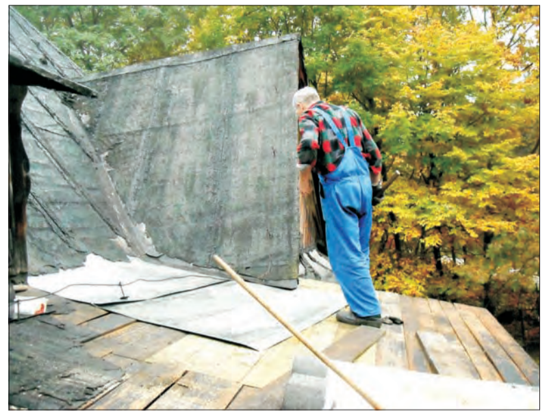
Wojciech Bogaciński sam wyremontował dach.
