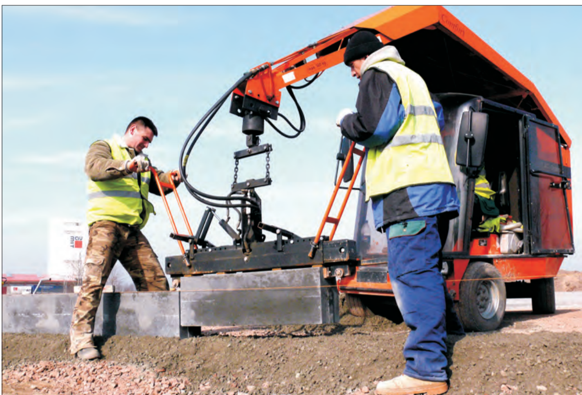
Lada dzień kładziony będzie asfalt na rondzie u zbiegu ulic Prymasowskiej i Łódzkiej w Łowiczu. Więcej na ten temat - na str. 5.
