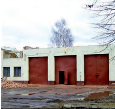
Stara remiza OSP w Łyszkowicach jest już w części rozebrana.
