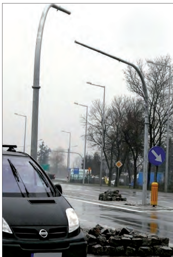
Wysięgniki, na których zawisną światła już są postawione.
