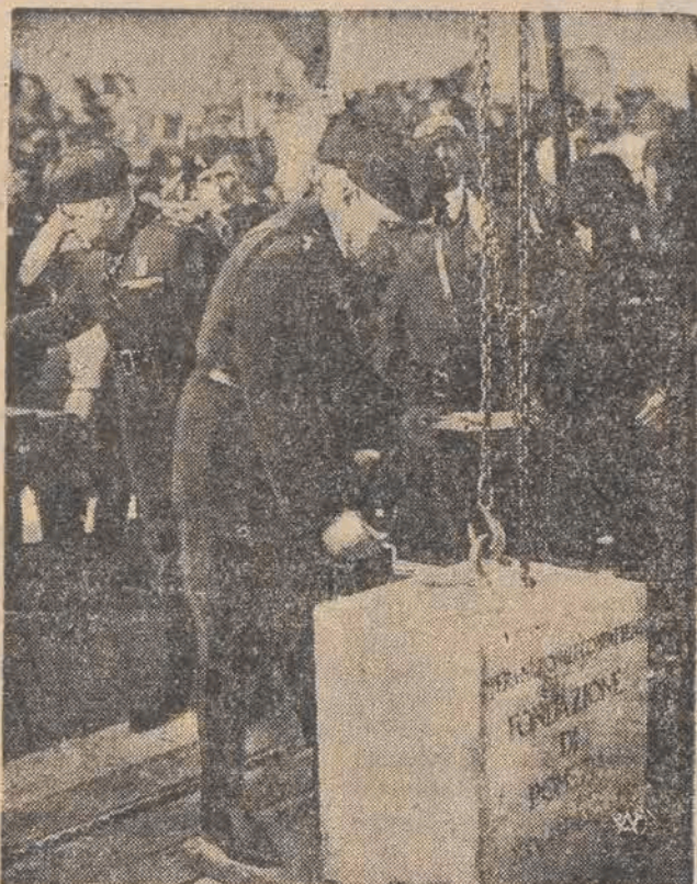
W dniu 25 kwietnia, Mussolini założył kamień węgielny pod budowę nowego, czwartego już z rzędu miasta włoskiego, które otrzyma nazwę Pomezia.
