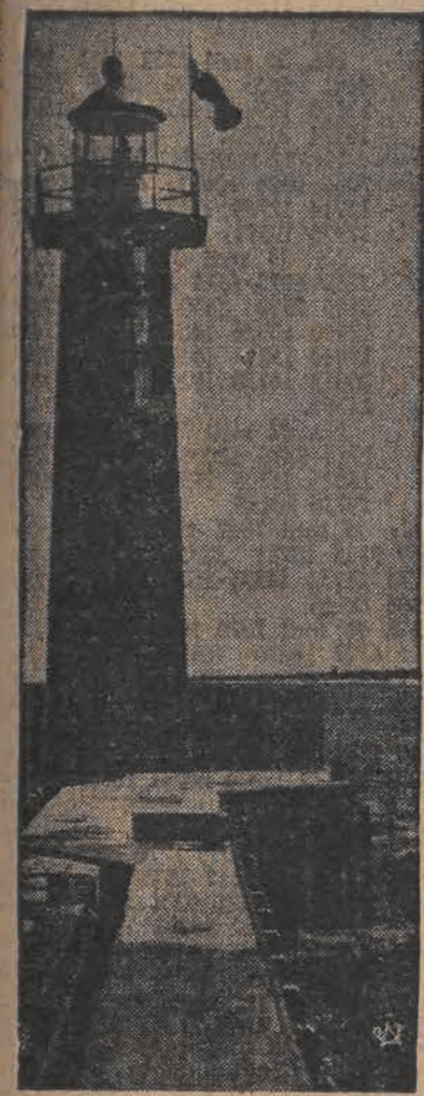
Nowozbudowana latarnia morską we Władysławowie.
