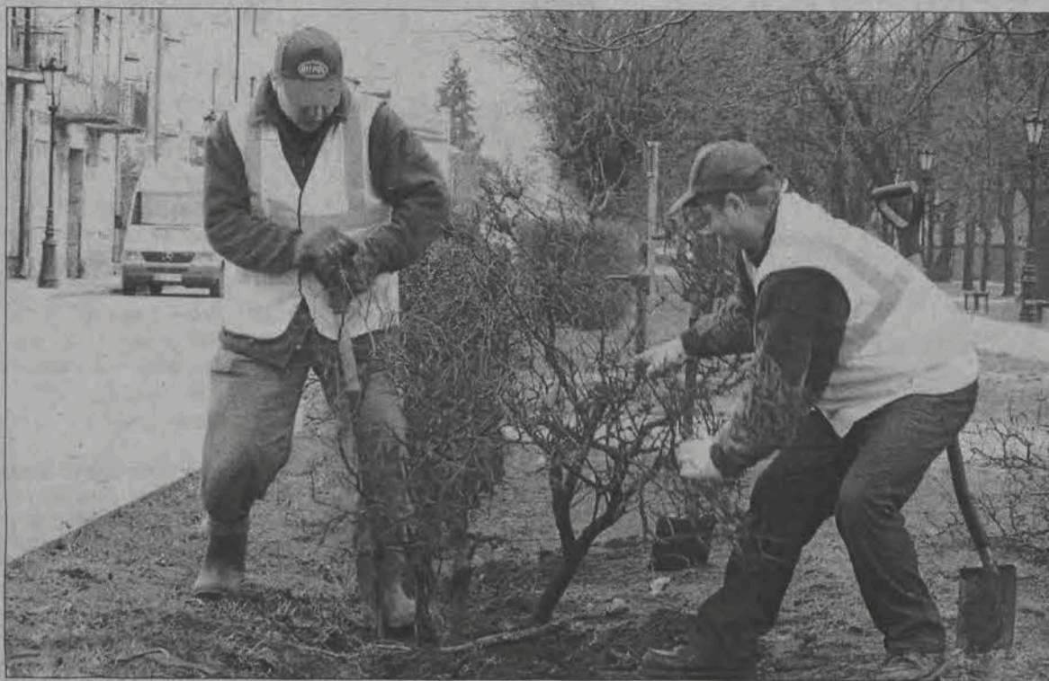
Pracownicy Gitpolu rozpoczęli prace w Parku Sienkiewicza od usunięcia żywopłotu.
