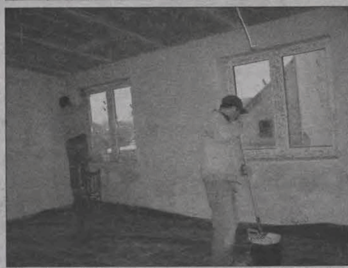
Folia okrywa już terakotę na podłodze przed pobrudzeniem, ściany i sufit czekają tylko na pędzel.
