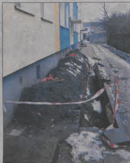
Ten wykop straszy od ponad czterech tygodni mieszkańców bloku nr 3 na osiedlu Tkaczew. Dziś, jeśli pozwoli na to temperatura, ma zniknąć.
