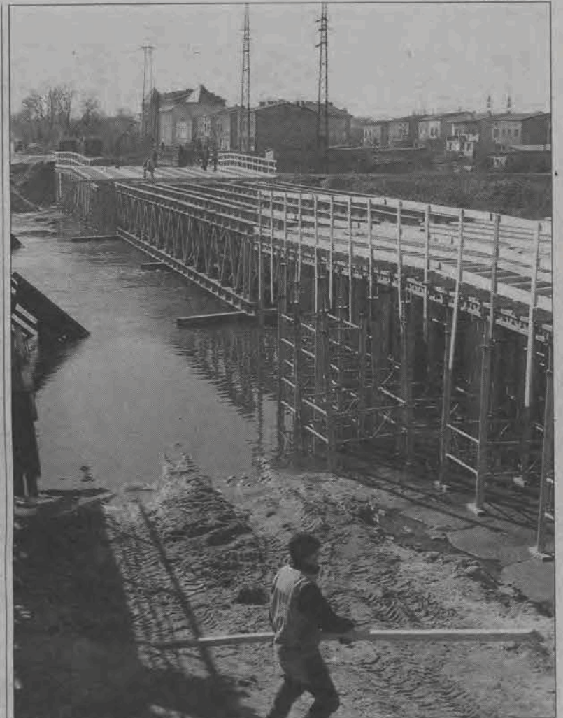
Metalowa konstrukcja mostu w ciągu ulicy Warszawskiej już stoi. Wysoki stan Bzury nie przeszkadzał w żaden sposób budowlącom.
