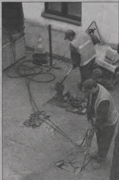
W środę, 13 kwietnia, uzupełniono dziury w asfalcie na ul. Pijarskiej.
