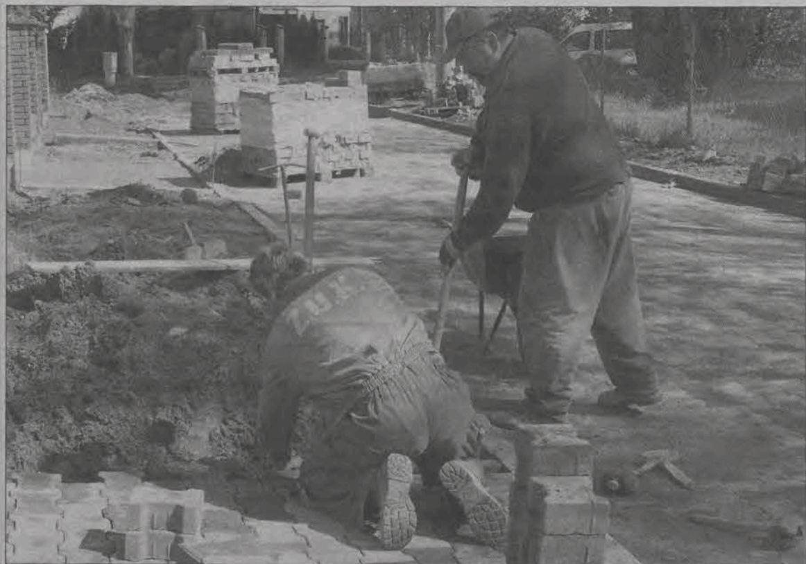
Prace przy układaniu kostki betonowej na ulicy Kwiatowej prowadzi brygada łowickiego Zakładu Usług Komunalnych.
