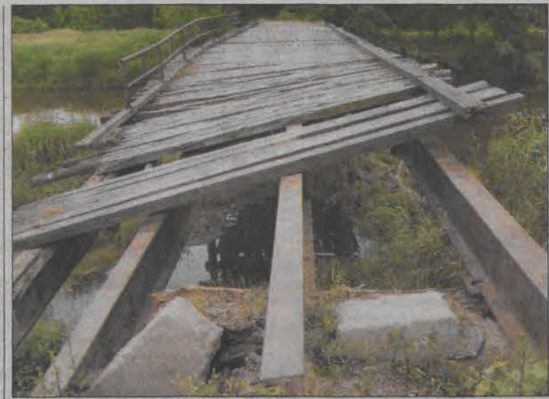
Most w Popowie ma być rozebrany w II połowie tego lub w przyszłym roku.
