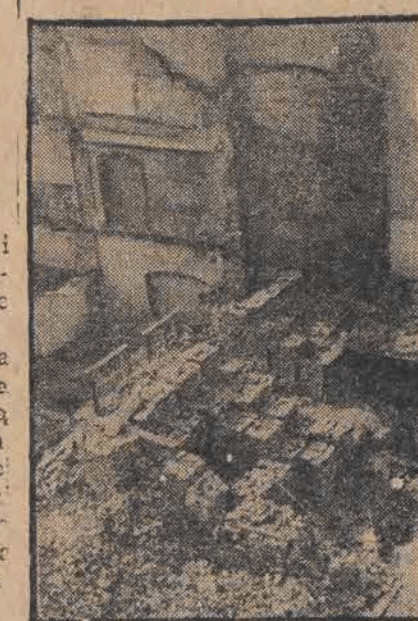
Kamienica przy ul. S-to Jerskiej 24, znajdująca się w trakcie rozbioru
