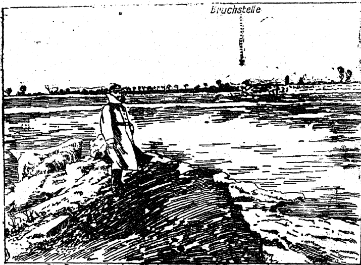
Die Bruchstelle des Elbdammes bei Berge.
