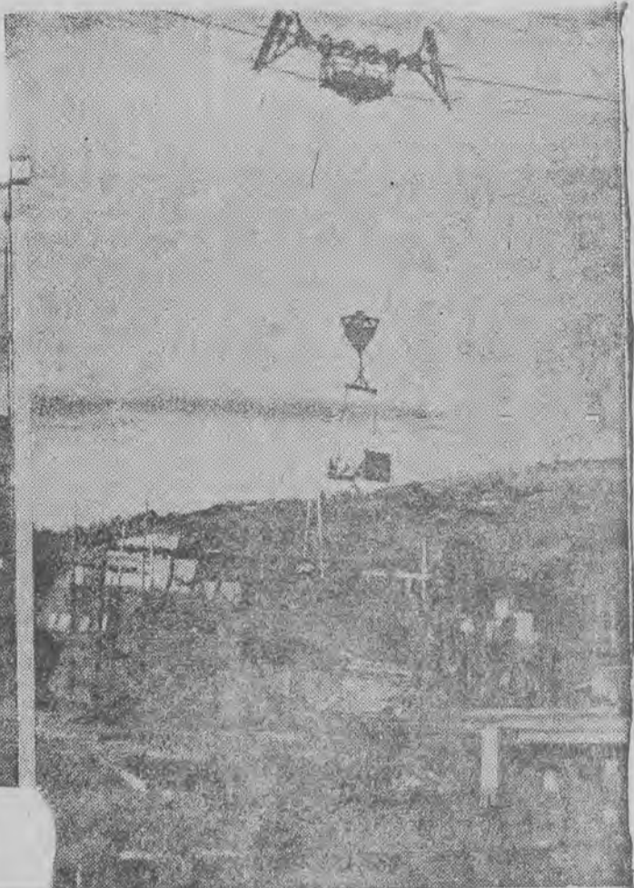
Roźńó Nr. 1 nie wystarcza dla naszych potrzeb elektryfikacyjnych i „ambicji energetycznych”: w Czechowie (województwo krakowskie) buduje się zapórę wodną drugą pod względem wielkości w Polsce. Otwarcie jej przewiduje się już na r. 1948.
