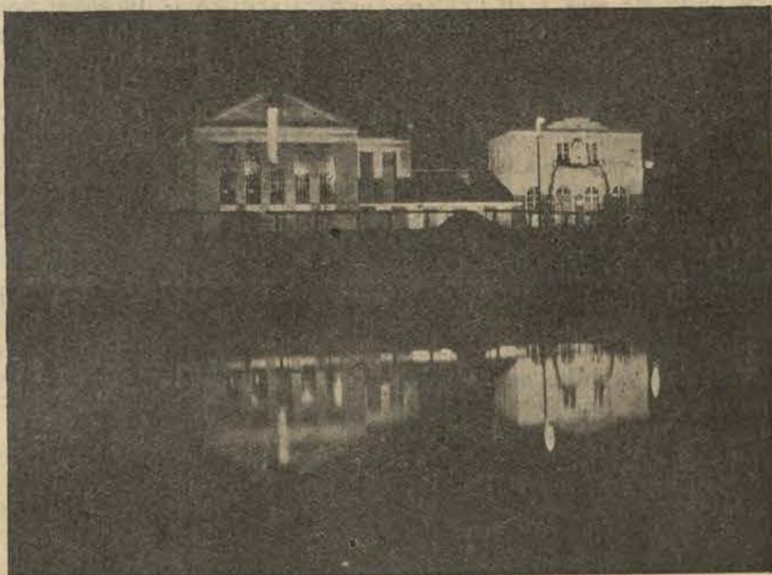
Iluminacja Łowickiej Elektrowni Okręgowej.
