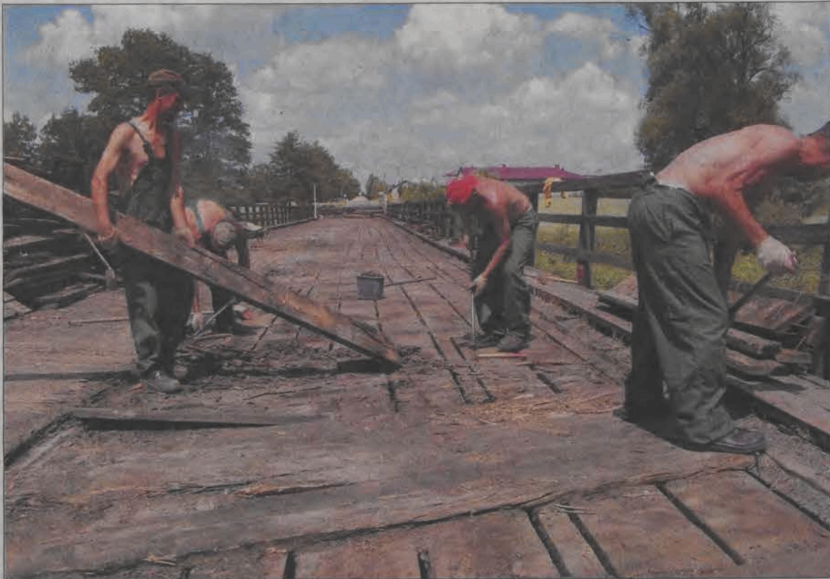
Po zdarceniu asfaltu od początku tygodnia na moście zdejmowana jest wierzchnia warstwa podkładów.
