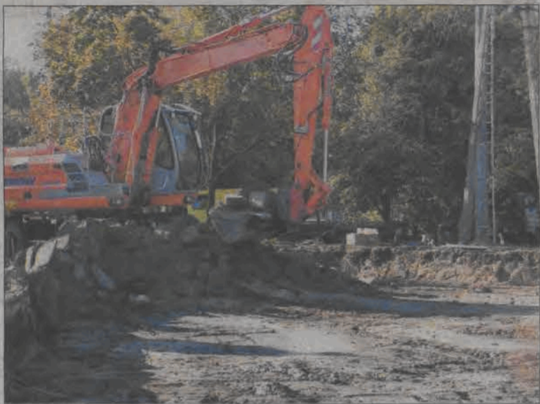
Na razie zamiast skrzyżowania ulicy Bolimowskiej z Warszawską jest dziura w ziemi na głębokość około metra.
