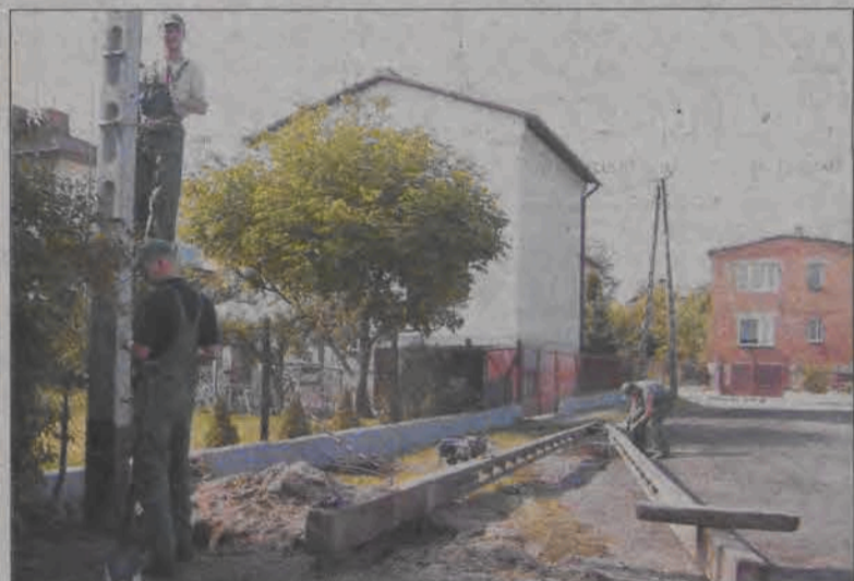
Pracownicy łowickiej firmy ABIR wymienili już jeden słup energetyczny na ul. Zielonej, drugi zaś przesunęli. Tego typu korekta konieczna była ze względu na to, że słupy stały w pasie drogowym mającej powstać ulicy.
