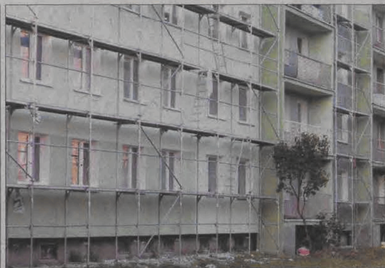
Blok nr 6 na Bratkowicach jest już ocieplony od północnej strony.
