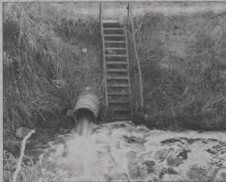
Przez tę rurę, ścieki po oczyszczeniu opuszczają miejską oczyszczalnię, w ostatnim czasie jednak to, co wylatuje z rury na oczyszczone nie wygląda.
