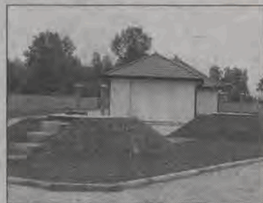
Odbiór stacji uzdatniania wody w Woli Stępowskiej planowany jest na piątek. Tak wyglądał jej teren kilka tygodni temu.
