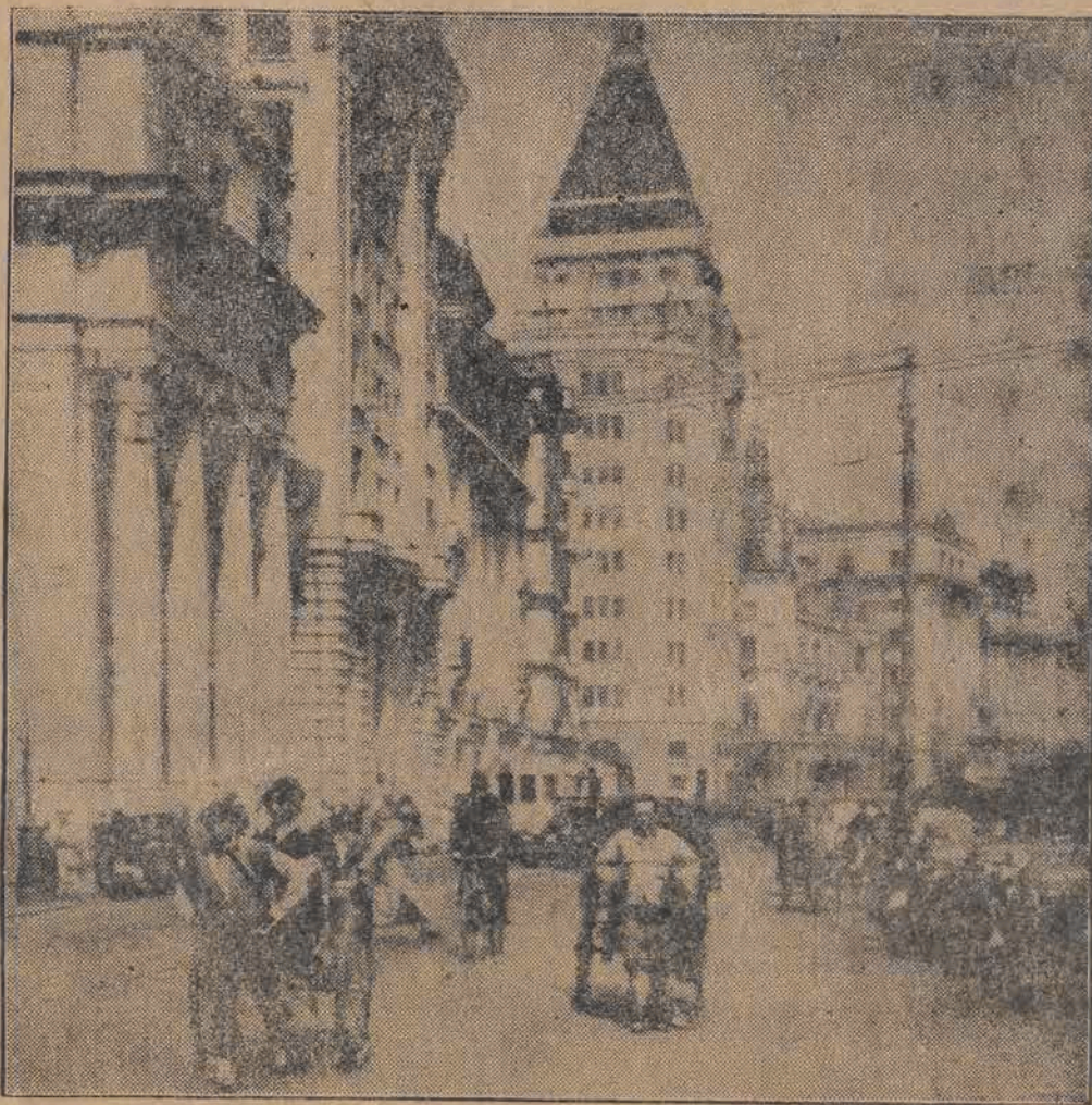
W dzielnicy europejskiej w Szanghaju, wybuchła w tych dniach bomba. Bomba spadła na angielski dom towarowy, który widzimy na zdjęciu. Siła wybuchu była straszliwa: dom został zniszczony.
