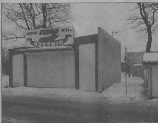
Zamknięty jeszcze sklep Rzeźnik na osiedlu Marii Konopnickiej - z prawej strony widać ścianę ognioodporną, którą musiał wybudować właściciel.
