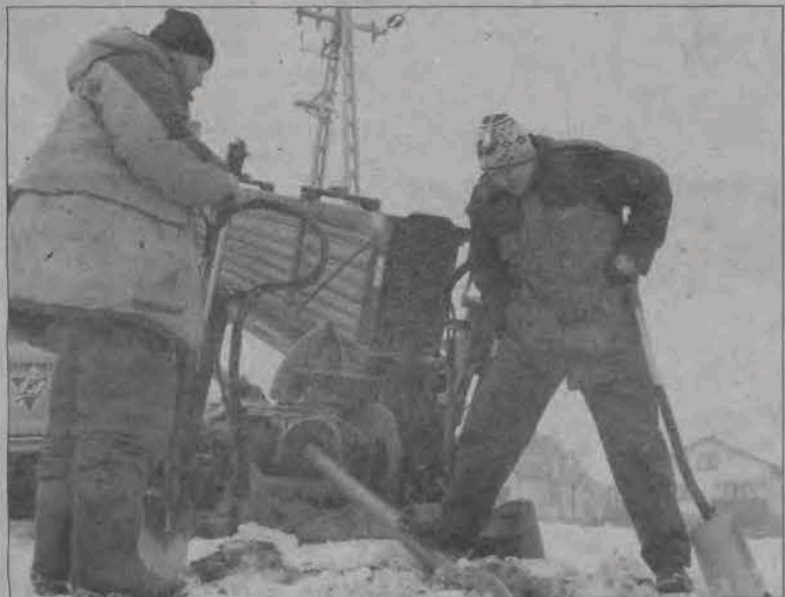
Robotnicy w Warszawskiej firmie w czasie rozpoczęcia prac przy wykonywaniu przecisku pod ul. Arkadyjską i rzeczką Zielkówką.
