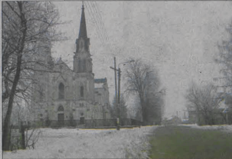
Teraz na poboczu drogi prowadzącej do nieborowskiego kościoła leży śnieg. Wkrótce ma być tam poprowadzony ciąg pieszy z kostki.
