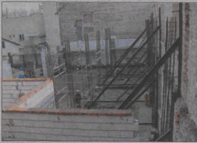
Została tylko frontowa ściana, za którą trwają prace budowlane.
