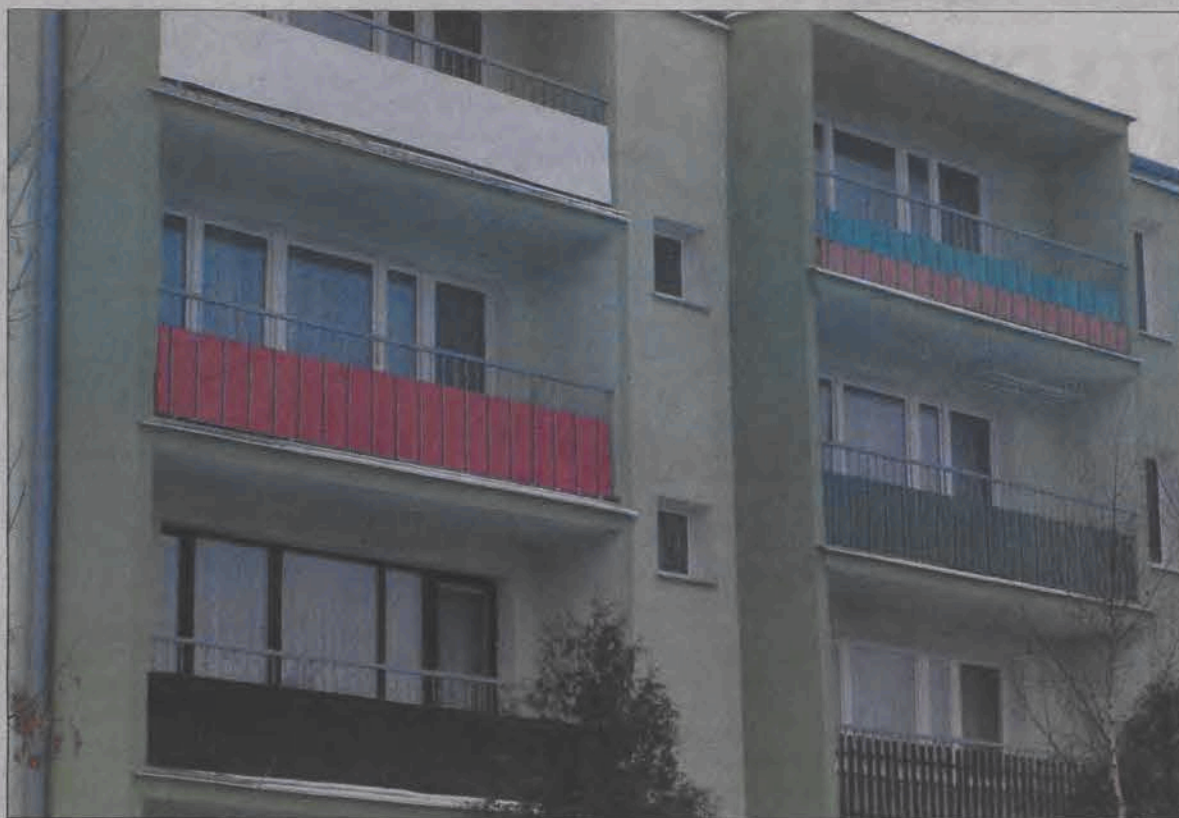
Docieplony w ubiegłym roku blok nr 6 na Bratkowicach zyskał kolorystykę zieloną.
