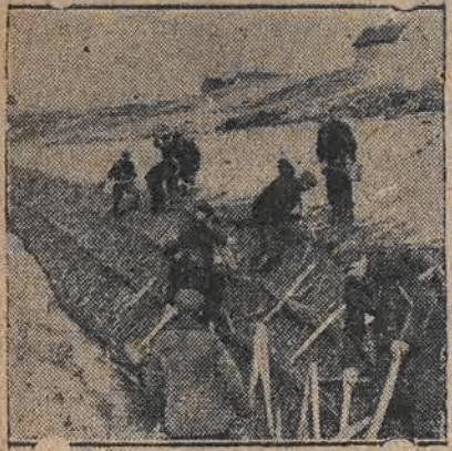
Paszynowanie brzegów kanału.
