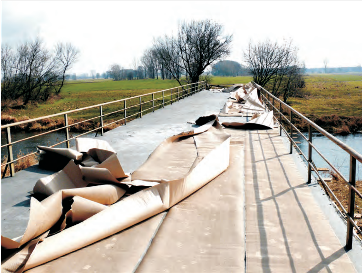
Beton na moście w Wierznowicach. Wójt gminy Zduny Jarosław Kwiatkowski powiedział nam, że przejazd przez most w Wierznowicach na drugą stronę Bzury będzie możliwy maksymalnie za dwa tygodnie. 12 marca wylano beton na zbrojenie. Ze względu na nocne temperatury utrzymujące się w okolicy zera, był on przykrywany karbowanym kartonem zapewniającym izolację. Ruch na moście będzie więc niedługo możliwy, choć prace na nim trwać mają do końca maja.
