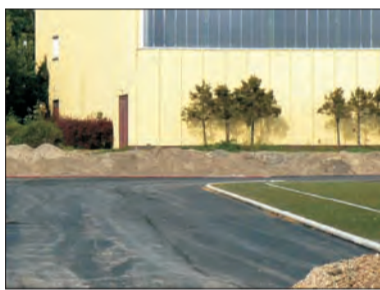
Pierwszą warstwę bieżni - asfaltową wylano jesienią ubiegłego roku. Teraz wylana zostanie warstwa poliuretanowa.
