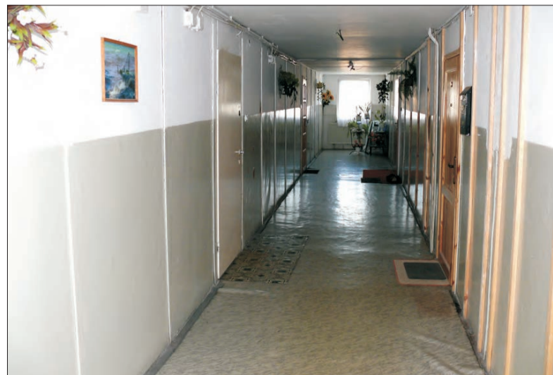
Na korytarzach wewnątrz budynku widać, że był to kiedyś hotel robotniczy. Część instalacji elektrycznych poprowadzona jest na ścianach. Na podłodze gumoleum, które paląc się, wytwarza dużo dymu. Lokatorzy dbają o wygląd korytarzy: są obrazki na ścianach i kwiaty.
