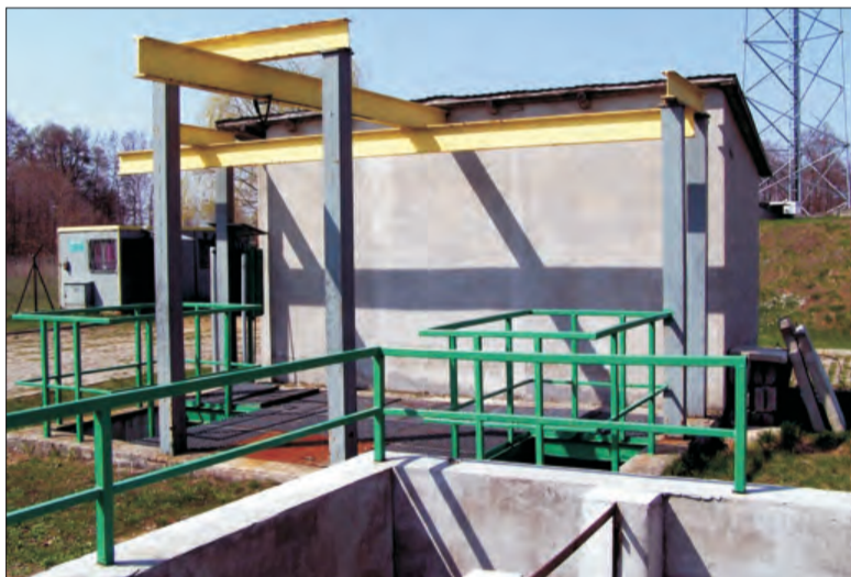
Bolimowska oczyszczalnia będzie gruntownie modernizowana. Prace rozpoczyna się w czerwcu. (eb)
