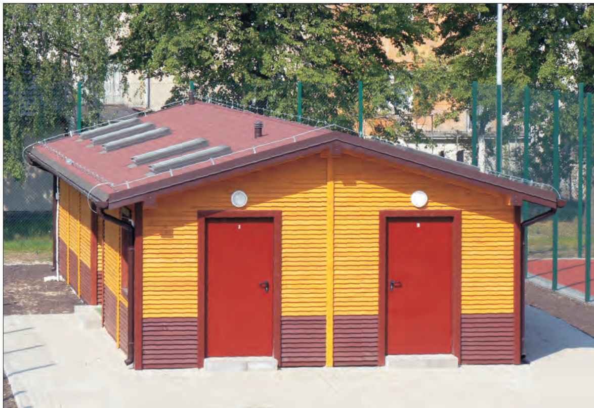
BUDYNEK PRZY ORLIKU JUŻ GOTOWY. Od 20 maja będzie użytkowany budynek, który powstał przy boisku Orlik w Zespole Szkół przy ul. Grunwaldzkiej w Łowiczu. Odbiór budynku odbył się w pierwszych dniach maja. Budynek zaplecza socjalnego jest drewniany. Wewnątrz powstały szatnia, natryski i zaplecze trenera - opiekuna. Wykonawcą jego była firma łowickiego przedsiębiorcy Andrzeja Malczyka. Koszt jego wykonania to ponad 267 tys. zł. (mwk)
