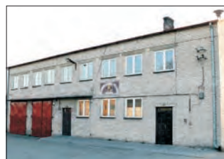
Niebawem rozpoczną się prace przy modernizacji remizy.
