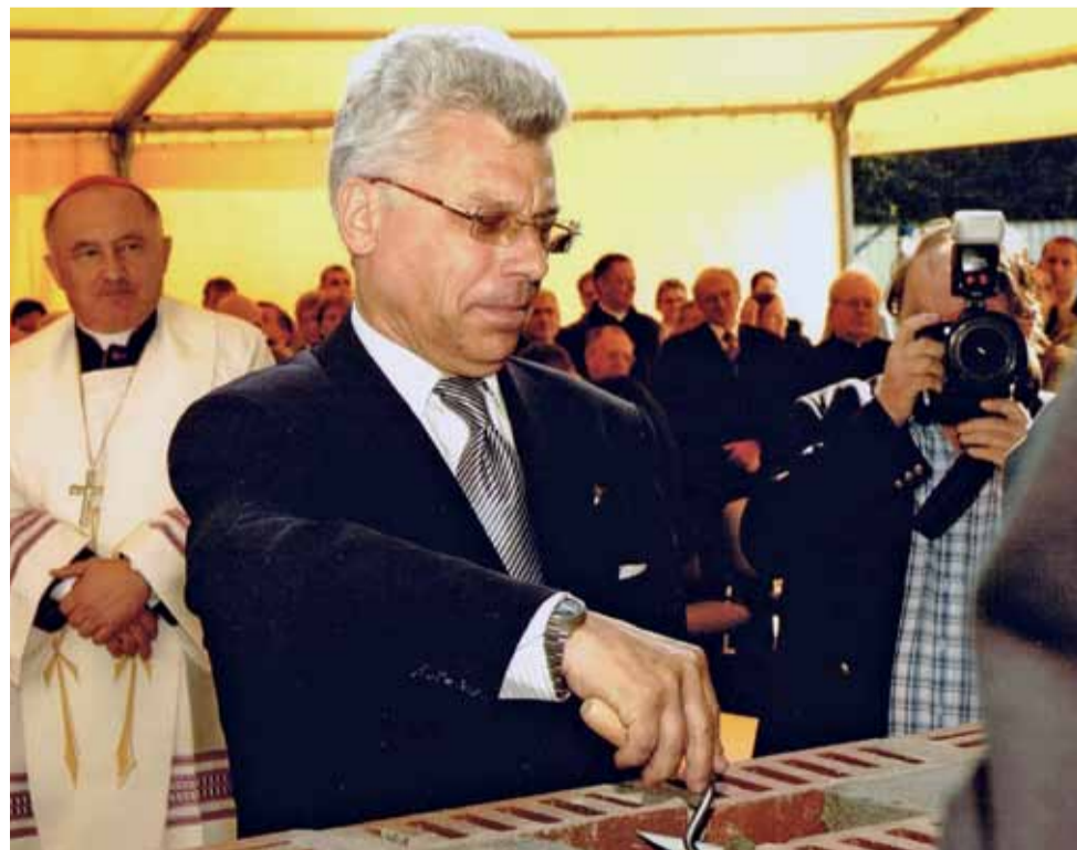
Wiesław Wysocki jako dziekan Wydziału Nauk Historycznych i Społecznych UKSW wmurowuje kamień węgielny pod nowy budynek wydziału, rok 2007.
