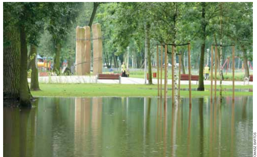
W środku lata Park Błonie w Łowiczu znowu był zalany – źle zamontowano kraty kanalizacji deszczowej. Po naprawie ma być lepiej.
