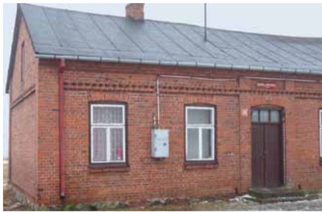
Budynek OSP w Krubinie zostanie zmodernizowany w pierwszej kolejności.
