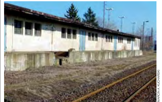
Rampa kolejowa oraz stare magazyny zbożowe mogą stać się – po gruntownym remoncie – jednym z elementów centrum logistycznego.
