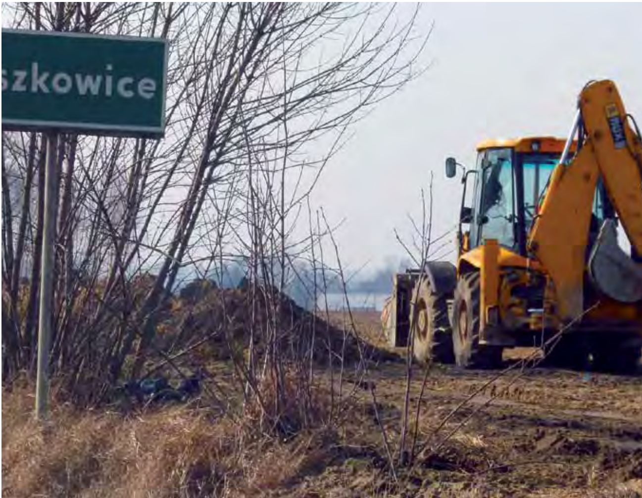
Budowa kanalizacji dotarła już do samych Łyszkowic.
