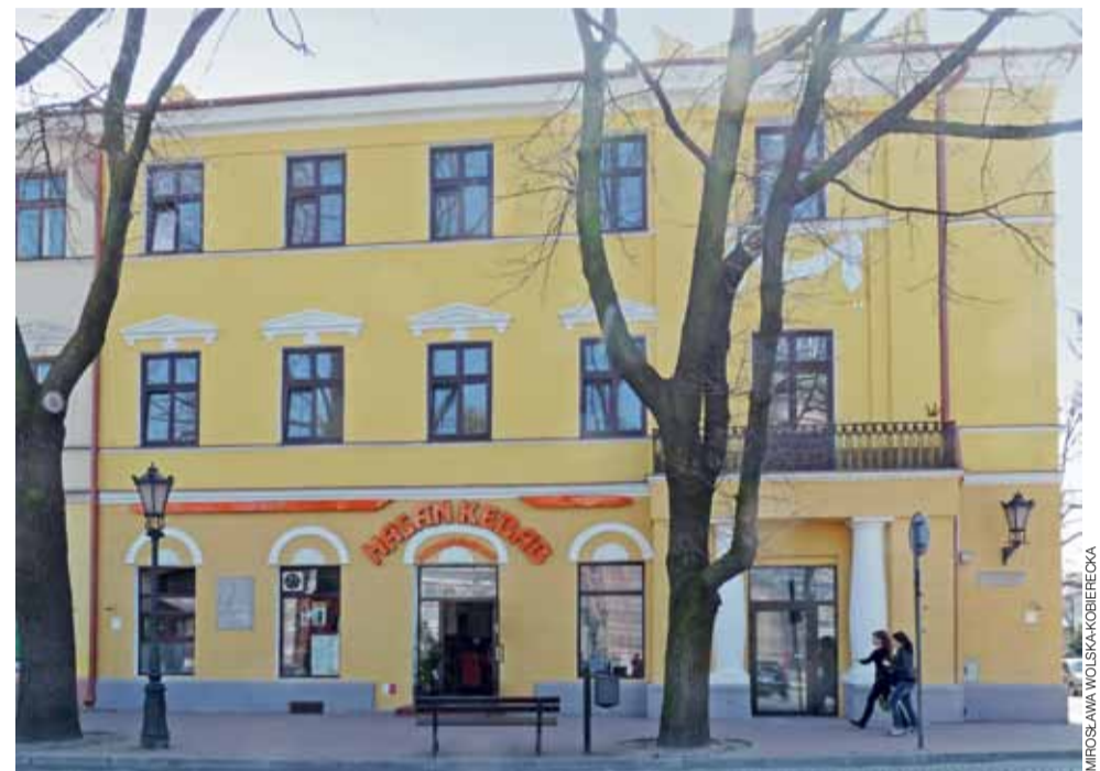
W Centrum Promocji mieszczą się informacja turystyczna, dom wycieczkowy i biura. W sali konferencyjnej na I piętrze komercyjnych kiermaszów ma nie być.
