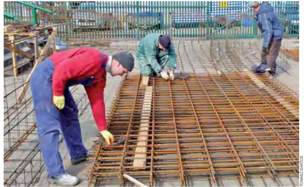
Przygotowywanie zbrojenia, które zostanie umieszczone w fundamentach, na których oprą się dźwigary podtrzymujące zadaszenie trybun.
