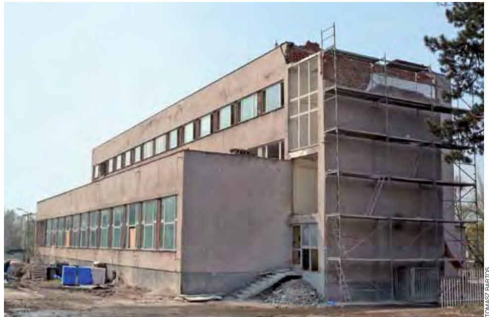
Budynek dawnego banku przy ul. Nowej, jest w tej chwili przygotowywany do adaptacji pod mieszkania.
