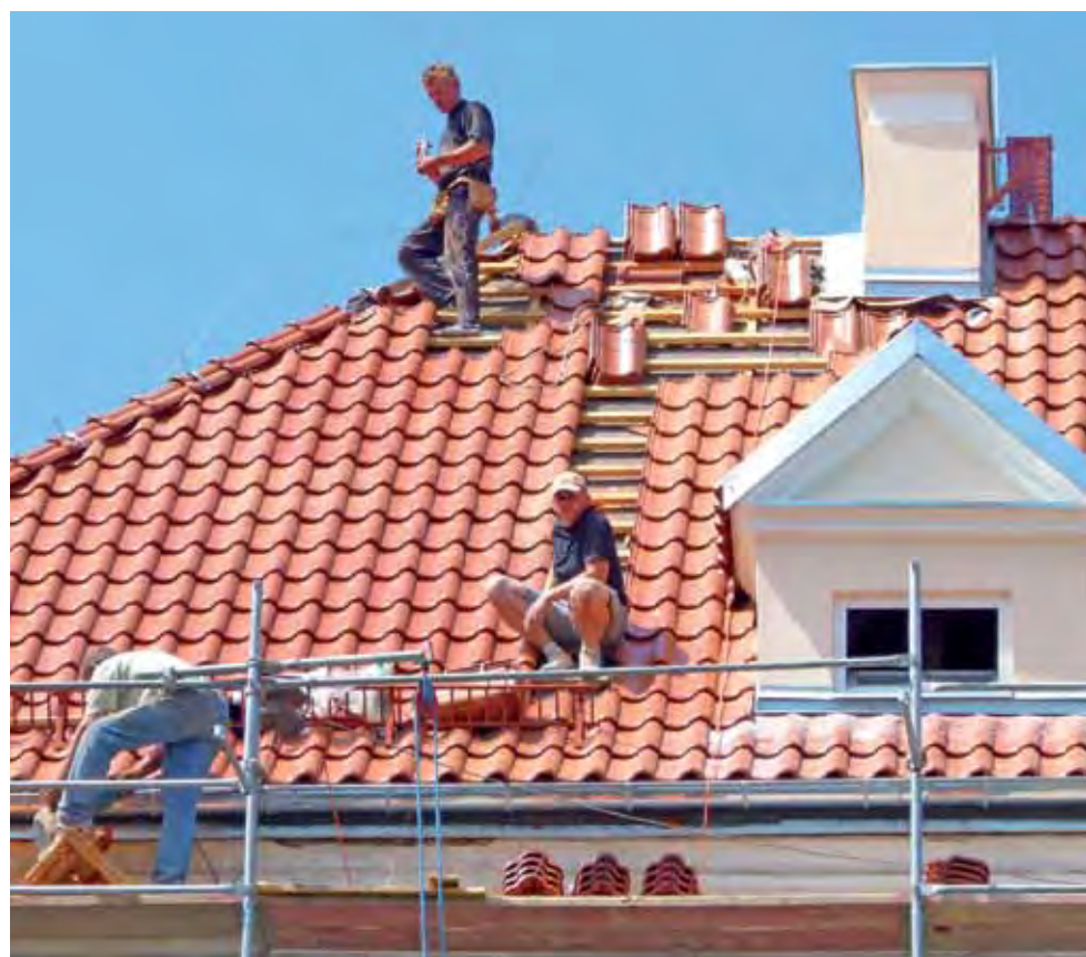
Wymiana dachówki powoli dobiega końca. Zdaniem właściciela firmy wykonującej remont, Jana Biernata, stara dachówka była w fatalnym stanie.
