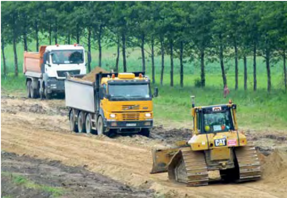
Na autostradzie ciężkich maszyn nie ma, ale pracują przy drogach technicznych.
