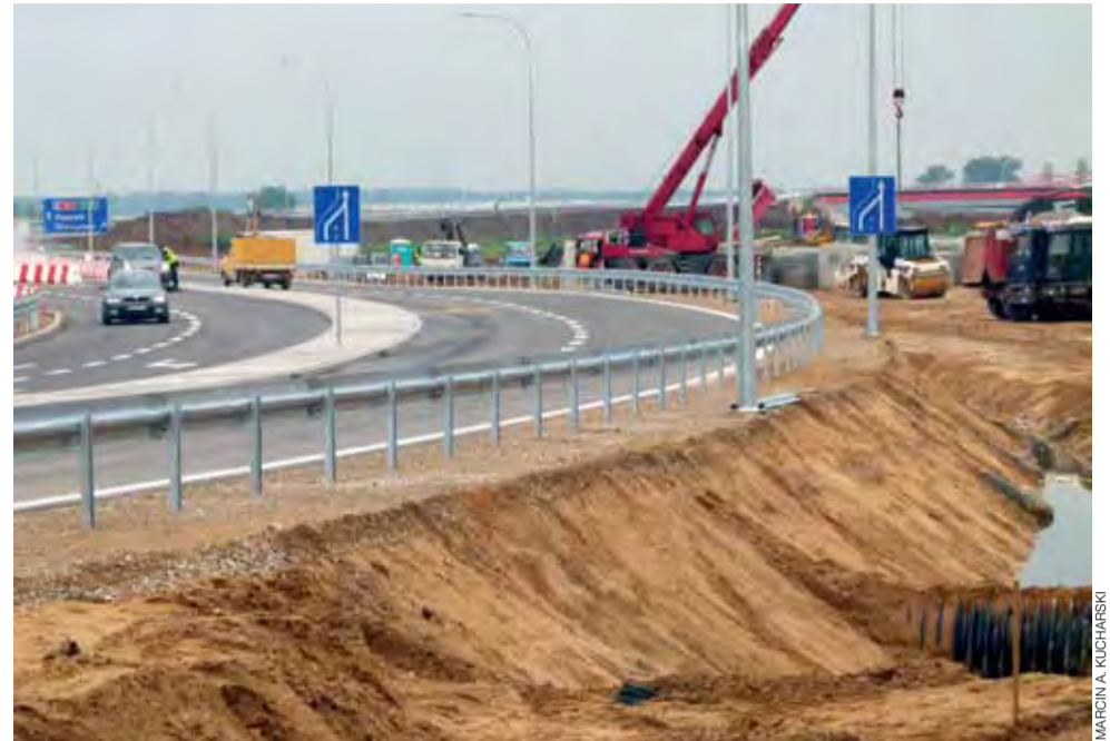
Węzeł w okolicach Łyszkowic w poniedziałek ciągle jeszcze wyglądał jak plac budowy.
