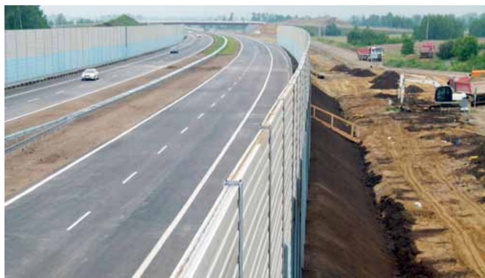
Wystarczy spojrzeć za ekran dźwiękochłonny, żeby przekonać się, że autostrada A2 to w znacznej części ciągle plac budowy.
